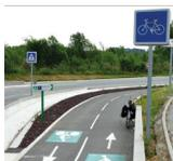
**Aménagement en site propre** : chaussée exclusivement réservée aux cycles à deux ou trois roues, séparée de la voirie par une bordure ou un espace délimité. C'est l'aménagement le plus sécurisant.
