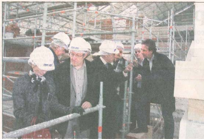
La délégation de l'association américaine qui se consacre à la préservation du patrimoine architectural français ne pouvait manquer le chantier consacré au petit Versailles lorrain.
